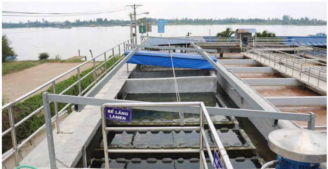
Hệ thống xử lý nước thải
